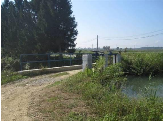
Slika 7. Brana na Stojnici
